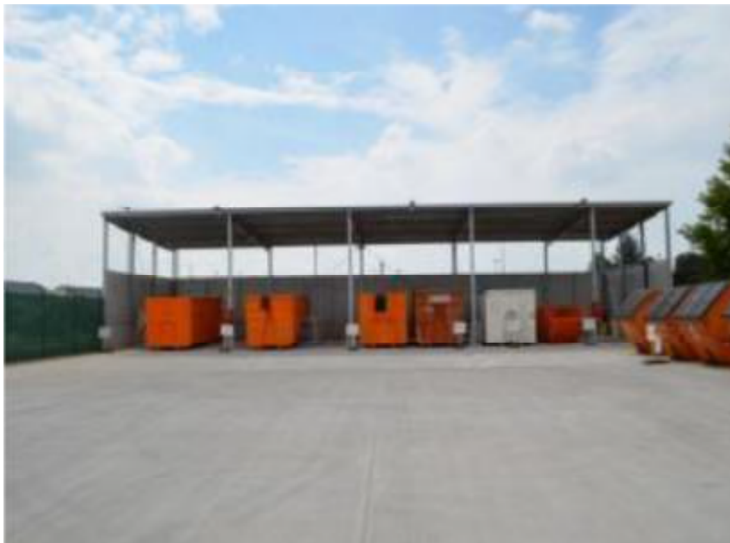
Εικόνα 6.14. Ενδεικτικά χώρος Πράσινου Σημείου
