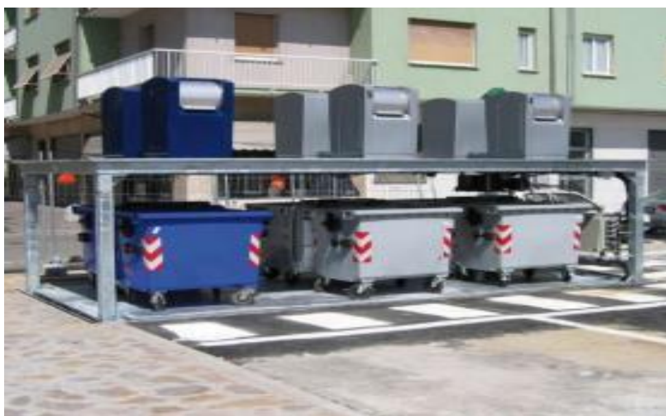
Εικόνα 29: Σύστημα βυθιζόμενων κάδων
