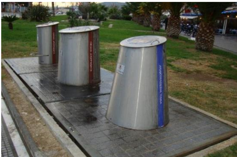
Εικόνα 28: Σύστημα βυθιζόμενων κάδων
