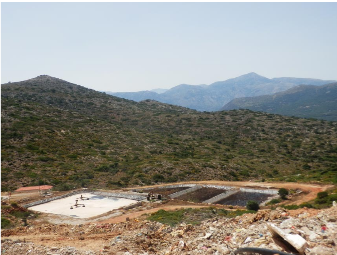
Εικόνα 2: Εγκαταστάσεις Χ.Υ.Τ.Α Χερσονήσου
