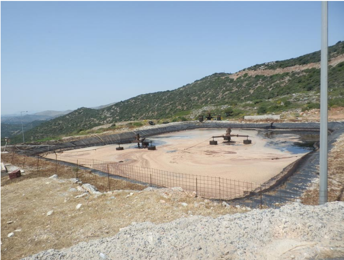
Εικόνα 3: Εγκαταστάσεις Χ.Υ.Τ.Α Χερσονήσου
